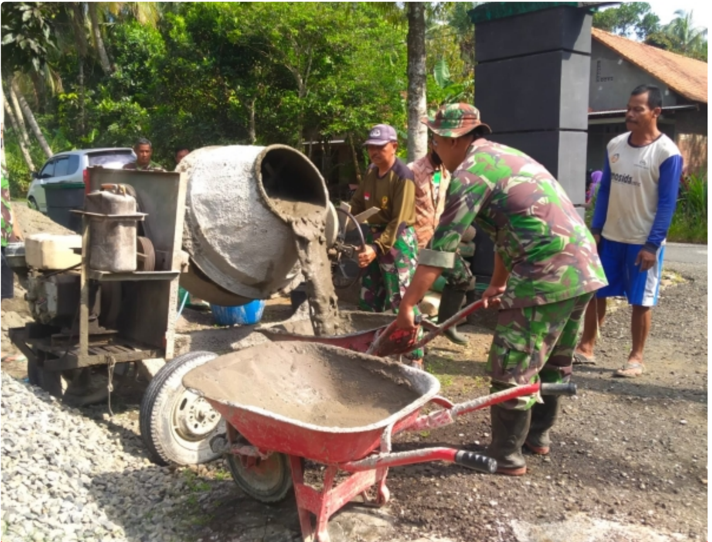
Anggota Posramil Bonorowo Bantu Warga Pengecoran Jalan
